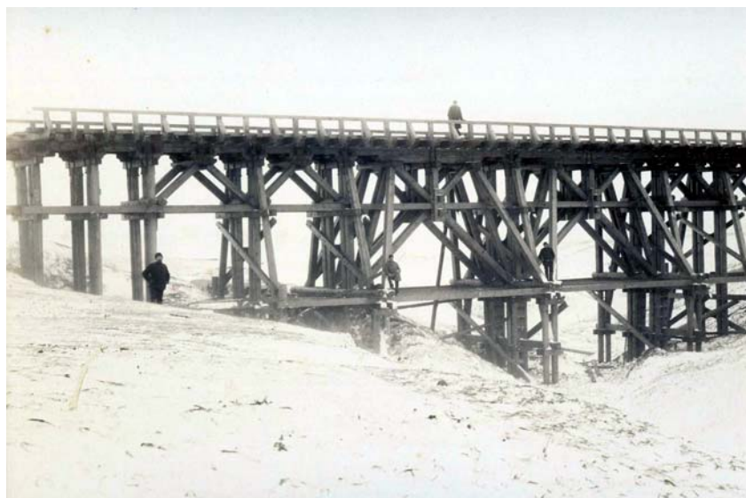
На строительстве железнодорожного моста через Орлов овраг.
